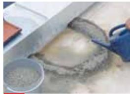
**4** 6. Dichtigkeitsprüfung der behandelten Reparaturstelle
